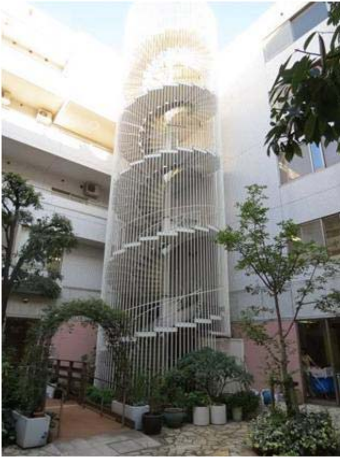
圖13 緊急逃生戶外樓梯(建置緊急滑梯)
