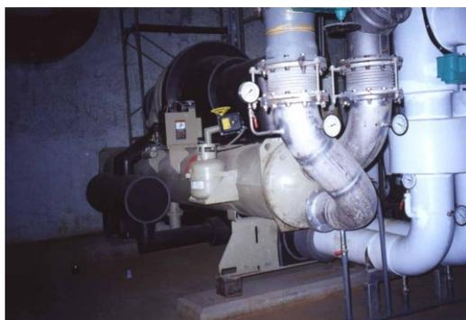
圖 3-9 中央空調系統之冰水主機
