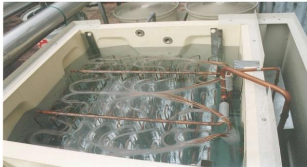
圖 4-12 儲冰槽內冷媒管路分佈情況
