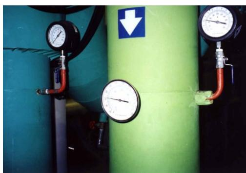
圖 3-10 空調機房管路壓力計
