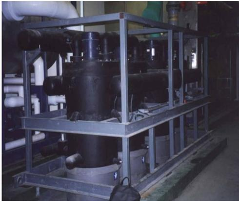
圖 3-11 原有之故障冰泥式蒸發器
