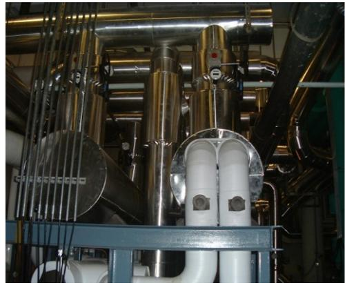
圖 3-12 新設之鹵水式蒸發器
