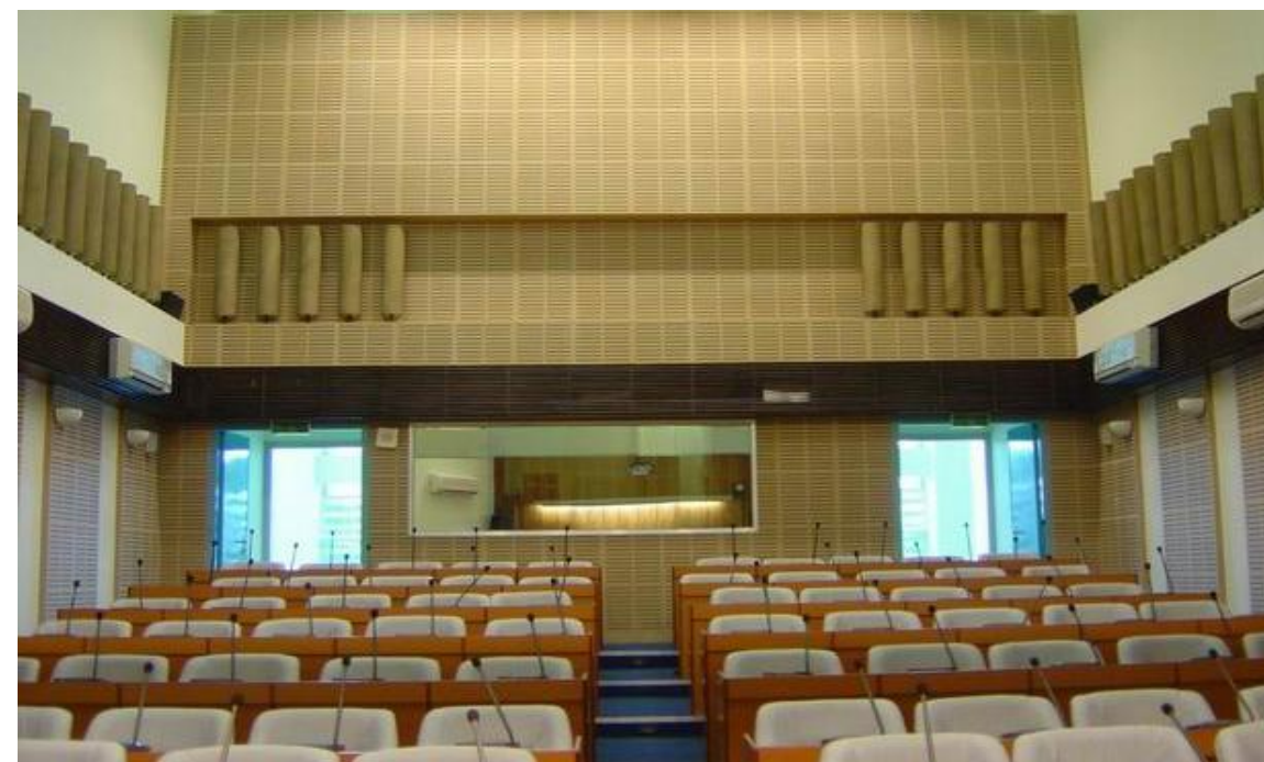
● 會議廳左右兩側與後側牆面加裝吸音性音效板與吸音筒
