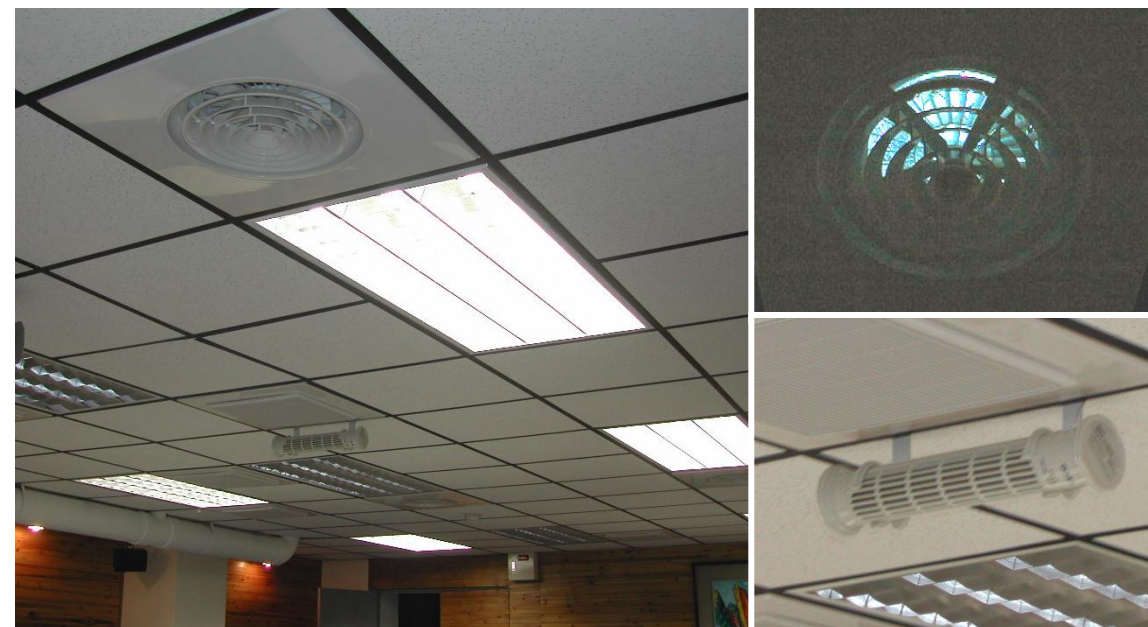
● 出風口加裝奈米光觸媒殺菌裝置及更換水漬天花板
