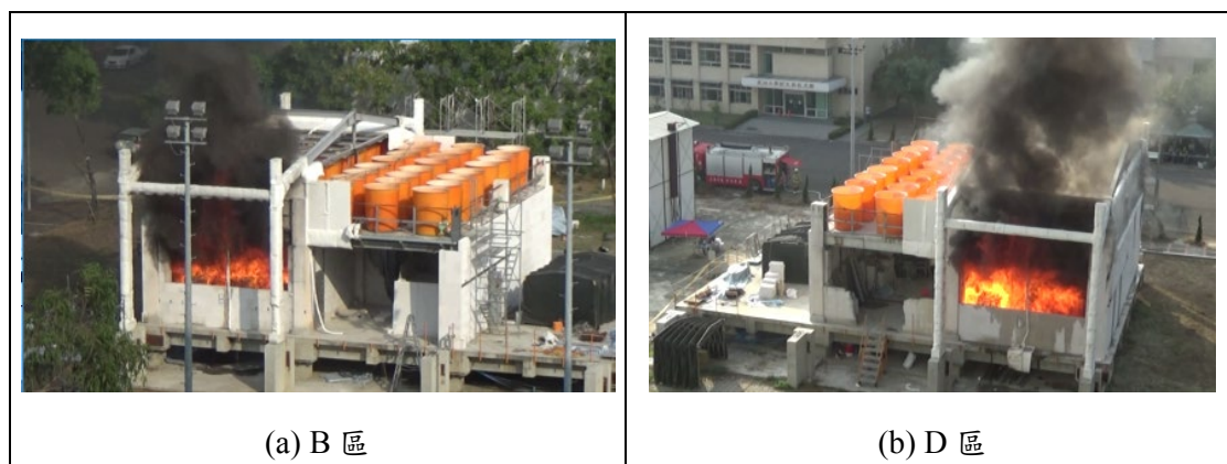
圖 5 鋼構實驗屋火害實驗照片
