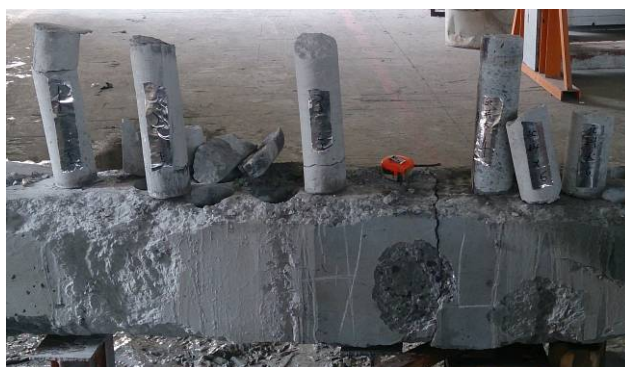
圖 12 混凝土鑽心取樣 (資料來源：本研究拍攝)
