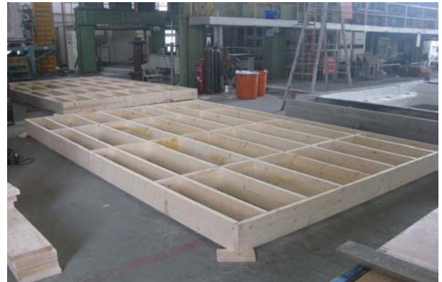
圖 2 第 I、II 組木樓板試體構架完成
