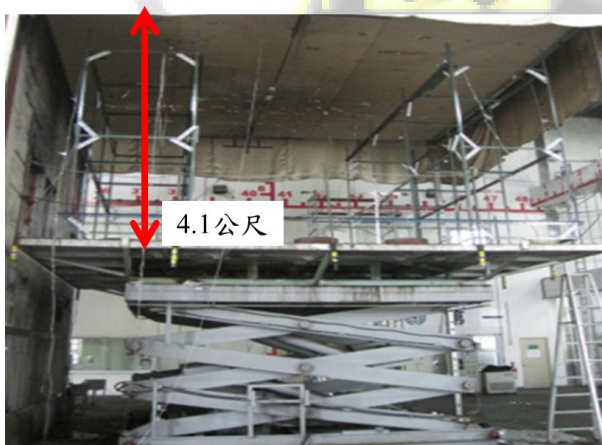
圖 5 天花板 4.1 公尺高側視圖
