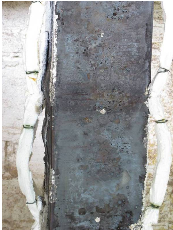
照片4：殘餘極限承載試驗試體破壞照片(2)
