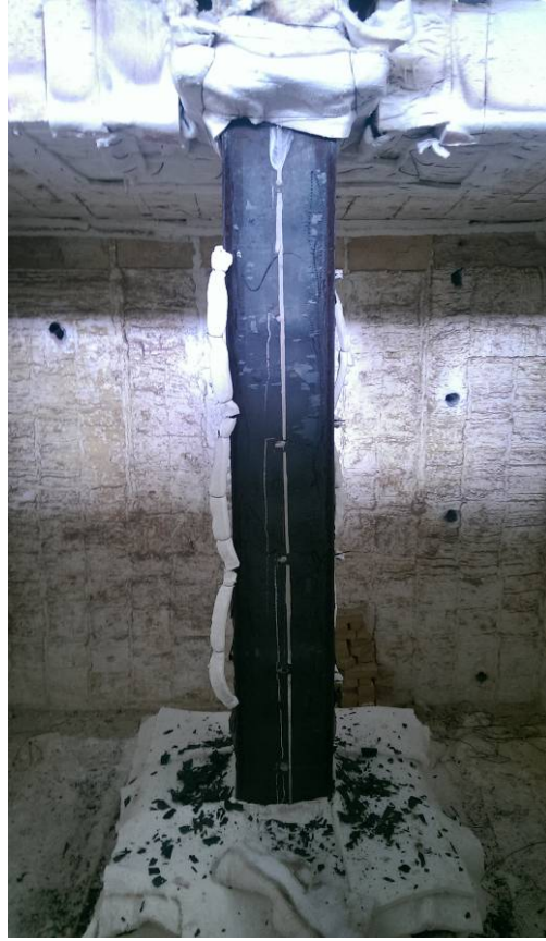
照片3：試驗後試體破壞情況(II)
