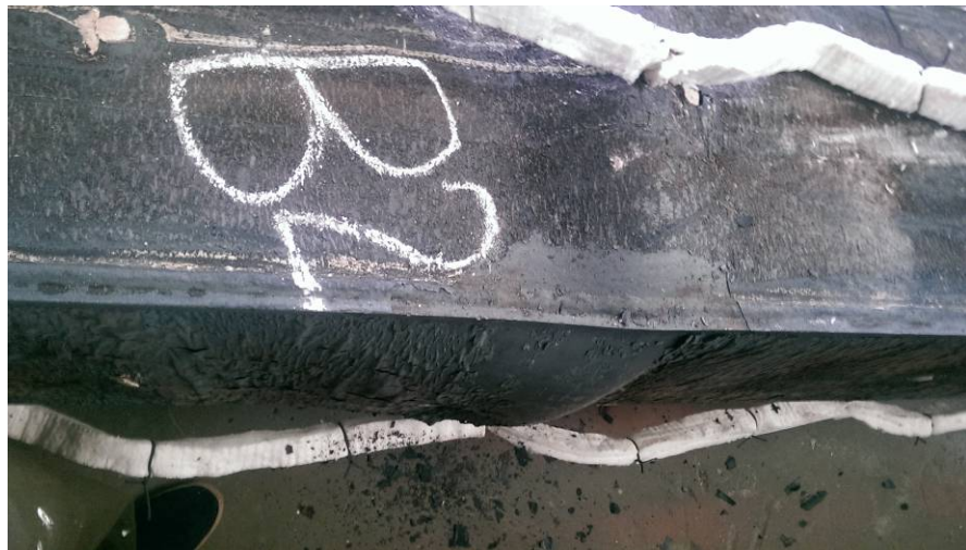
照片4：試驗後試體破壞情況(III)
