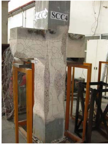
圖1 火害後鋼筋混凝土梁柱接頭試體
