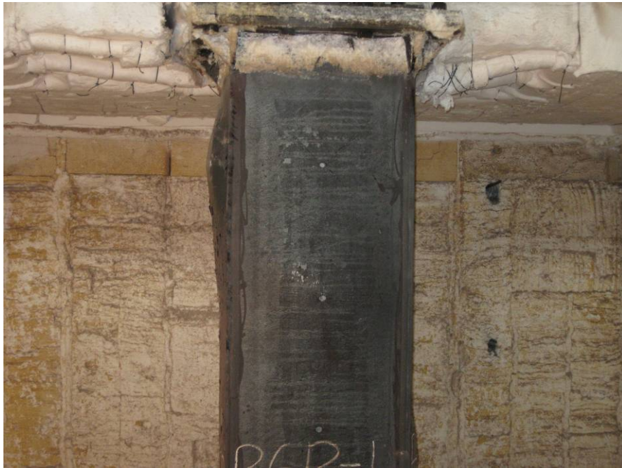
照片3：試驗後試體破壞情況(II)
