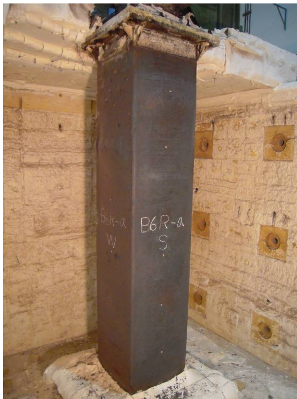
照片4：試驗後試體破壞情況(III)
