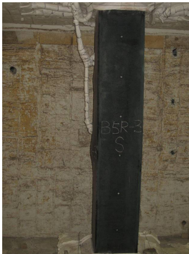
照片4：試驗後試體破壞情況(III)
