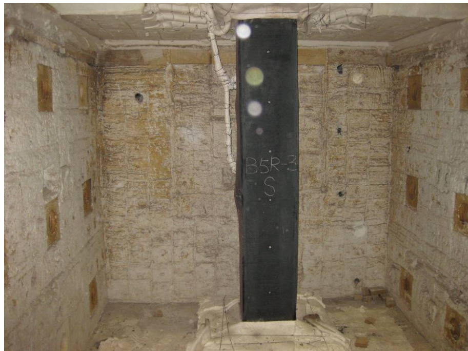
照片2：試驗後試體破壞情況(I)
