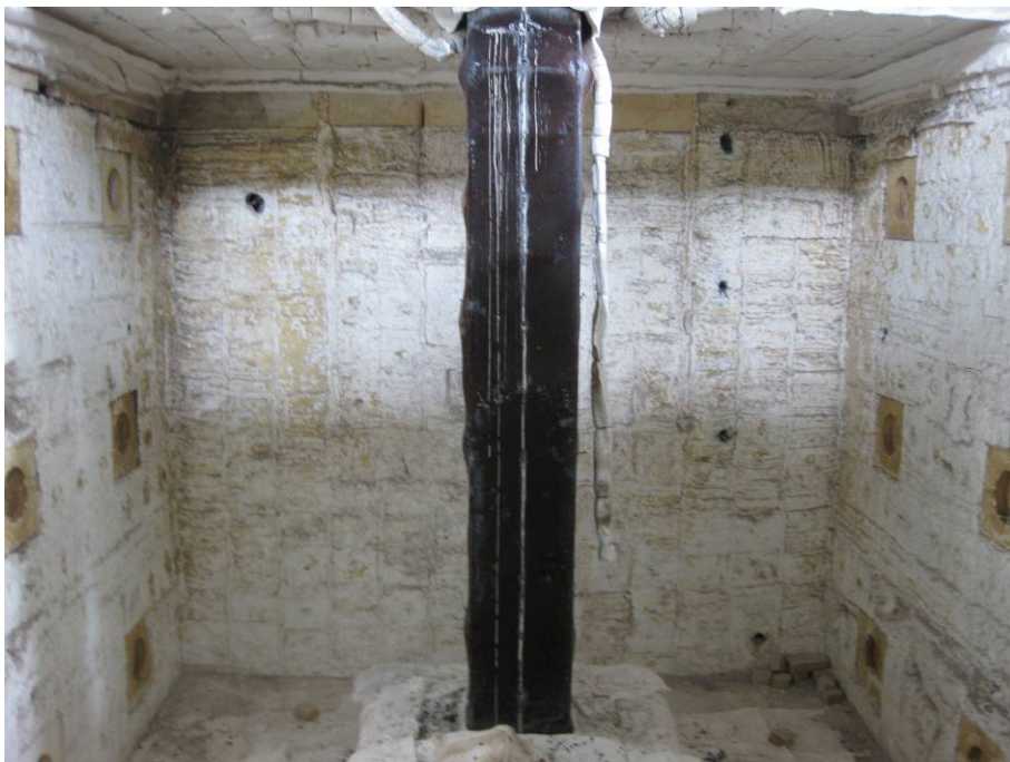
照片2：試驗後試體破壞情況(I)
