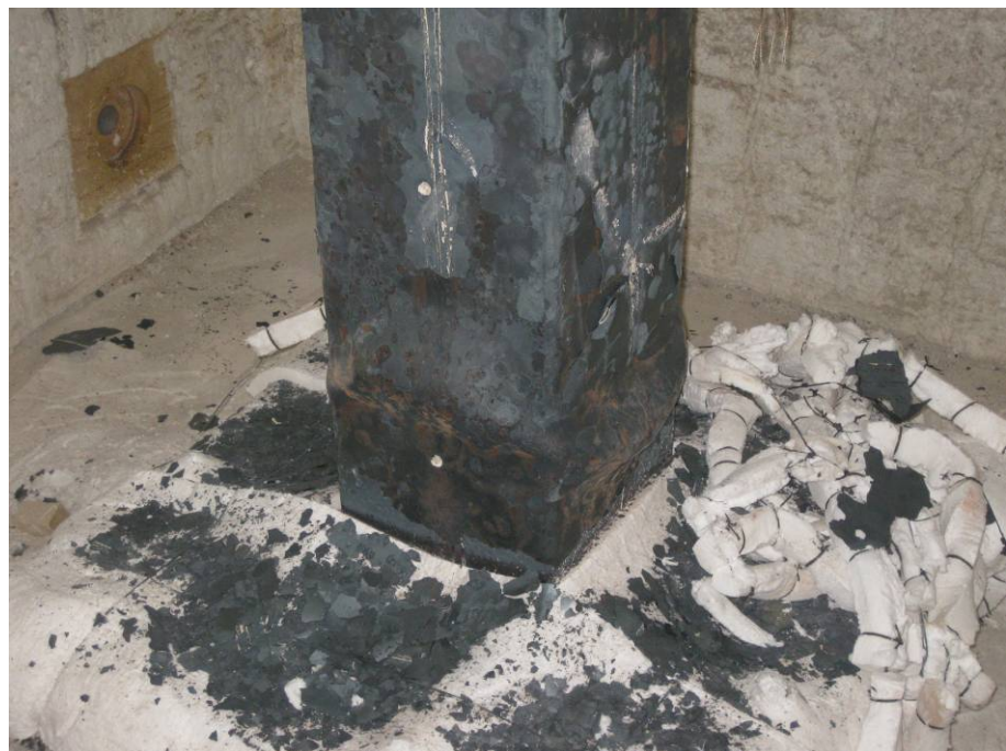
照片2：試驗後柱底試體破壞情況(II)
