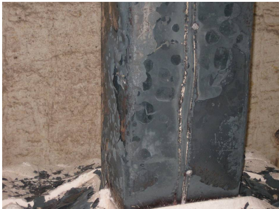
照片4：試驗後試體破壞情況(III)
