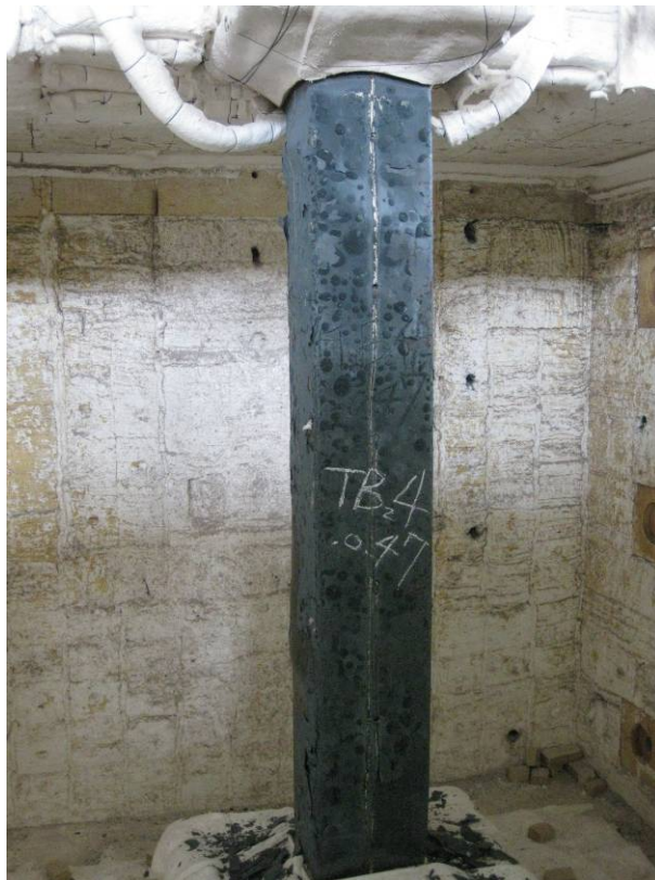
照片2：試驗後試體破壞情況(I)
