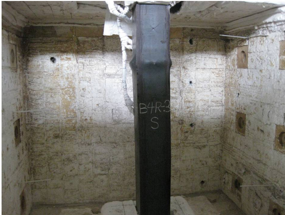
照片1：實驗後試體破壞情形(I)
