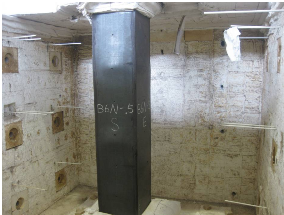
照片4：試驗後試體破壞情況(II)
