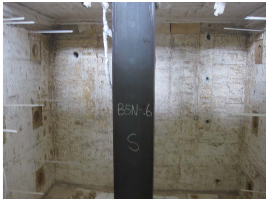
照片4：試驗後試體破壞情況)
