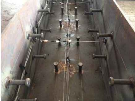
圖 5 箱型鋼柱組立成 U 字型後之熱電偶線安裝
