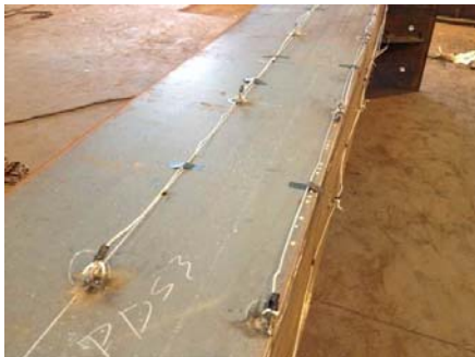
圖 6 箱型鋼柱鋼板外側之熱電偶線安裝
