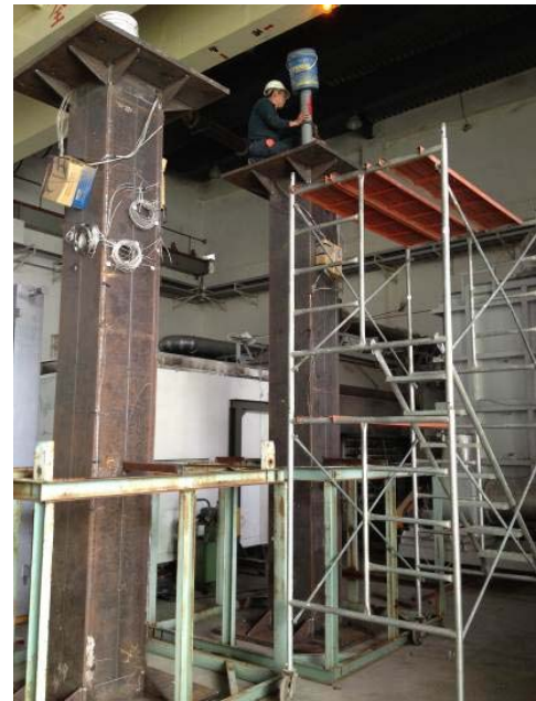
圖 7 箱型鋼柱之混凝土澆置
