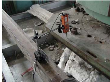
圖 10 量測柱整體軸向變形量之位移計設置
