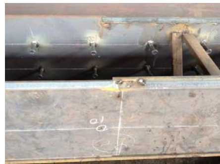
圖 4 箱型鋼柱之組裝過程中須輔以固定用點鉚
