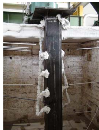
圖 11 試體於高溫實驗爐中之安裝
