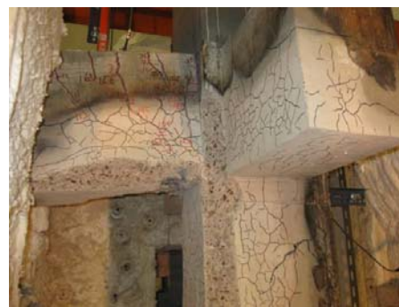
圖 19 SCC3 試體之破壞模式
