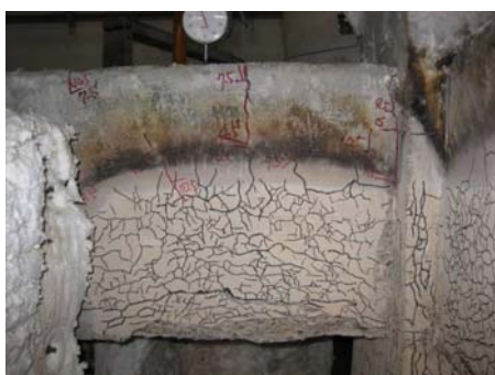
圖 21 NC3 試體於加載至 103 kN 發生梁底部混凝土剝落
