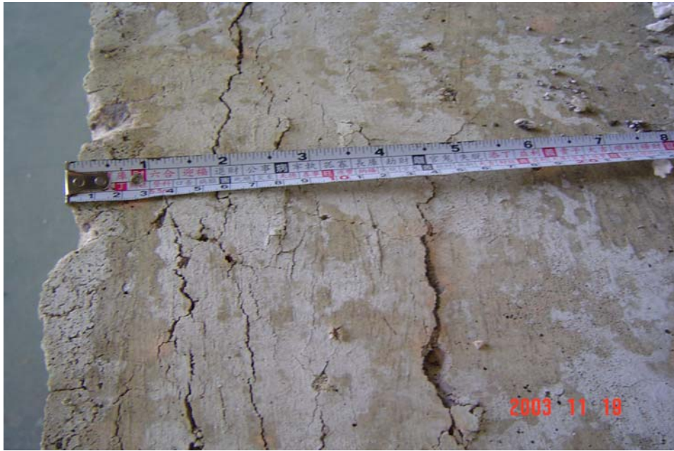
燃燒後試體發生龜裂現象
