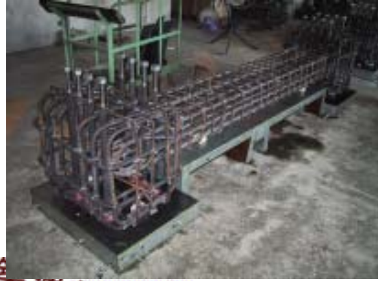
照片 3.6 柱頭鋼筋組立
