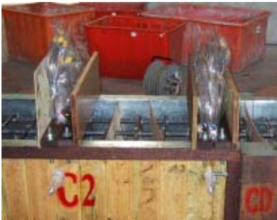
照片 3.3 熱偶計埋設
