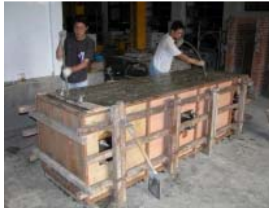
照片 3.12 柱墩灌漿情形
