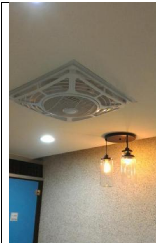
圖五 廁所內採機械換氣，減少廁所臭味。(來源：內政部建築研究所，2015)
