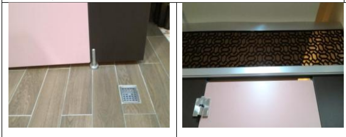
圖四 廁間門板下緣離地面離為 2 公分範圍內，門板上緣離地面應為 210 公分，並考量上緣到天花間之通風及隱密性。(來源：內政部建築研究所，2015)
