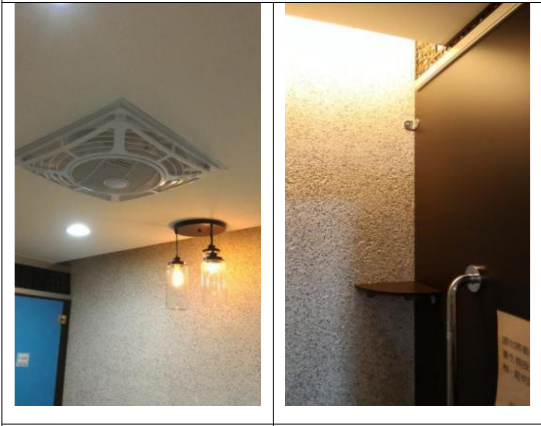
圖五 廁所內採機械換氣，減少廁所臭味。(來源：內政部建築研究所，2015)
