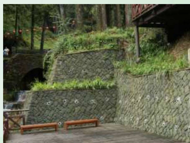
漿砌石護坡、休憩木座椅
