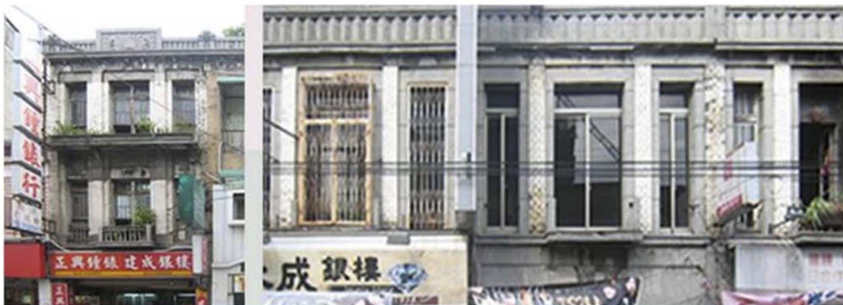
中正路街屋立面 員林中正路的垂直線條分割
