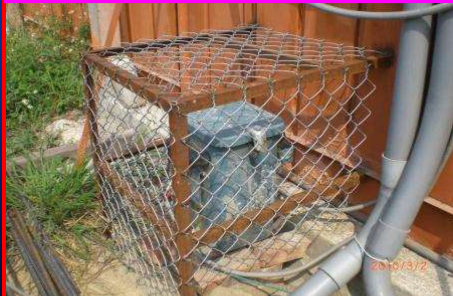
臨時電配電盤及變壓器圍設防護
