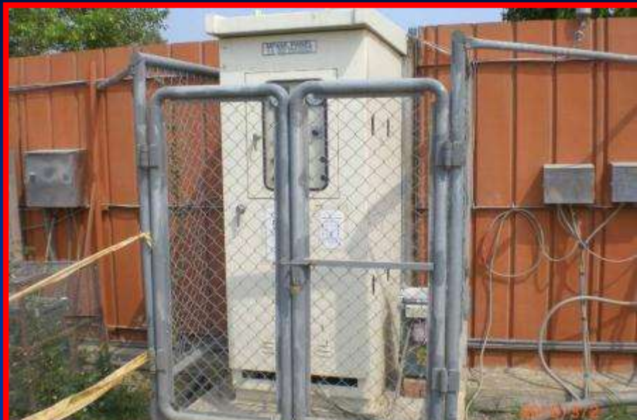
臨時電配電盤及變壓器圍設防護
