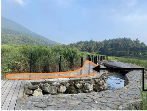
橘色圈選處有高低落差，堆積土方做成緩坡，消除現有地面落差，同時營造隆起的池岸。可以創造景觀，同時降低遊客進入的可能。
