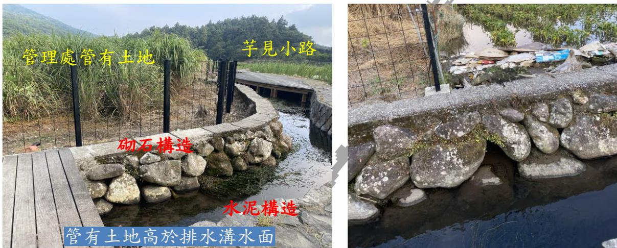
(a) 管有土地高於排水溝水面。因芋見小路工程施作而使溝渠兩岸有不同的溝壁構造。
