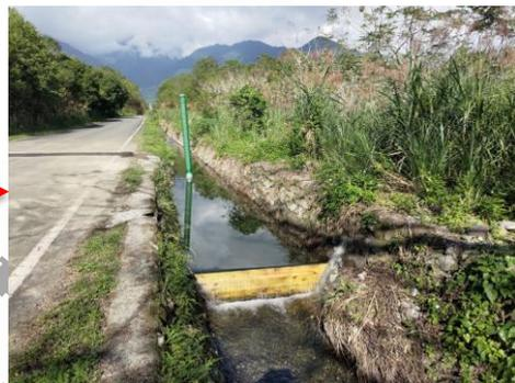
調節式水堤由多塊橫板組成，可以依需要抽出橫板，調節所需水位。移開所有橫板，可以利用水流來清淤和防洪。
