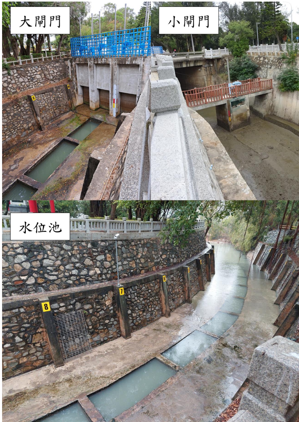
圖 2-2 慈湖大、小閘門及水位池
