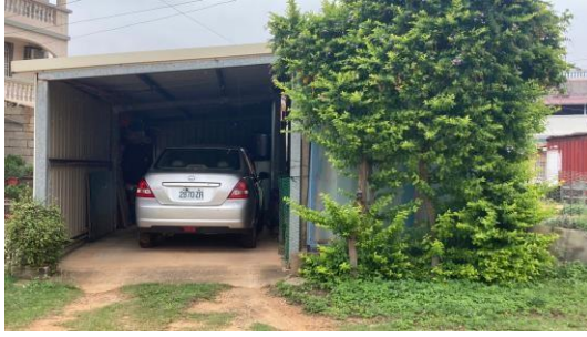
圖 2-25 車主自行搭設停車空間
