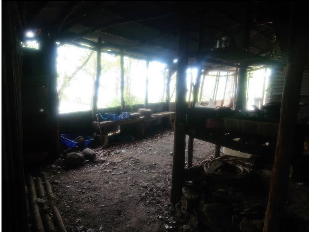
馬武霸線 1.5K 處大型工寮內部。
