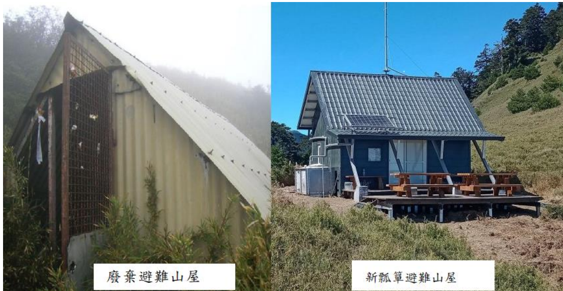
圖三、原有之廢棄避難山屋及原地新建之瓢箪避難山屋
