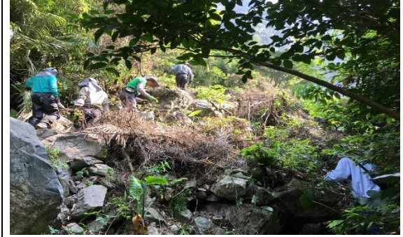
清除崩石坡上的小花蔓澤蘭蔓
