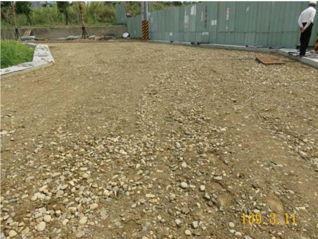
▶▶ 已施作道路碎石級配粒料經下雨沖刷後有粒料分離及鬆散不緊密之情形
