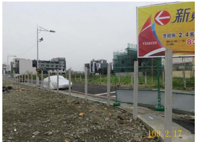
▶▶ 部分區域未設置圍籬，未能有效管制施工人員進出工地
