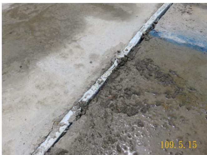
▶▶ 滯洪池箱涵頂版及側溝伸縮縫與混凝土不緊密結合
