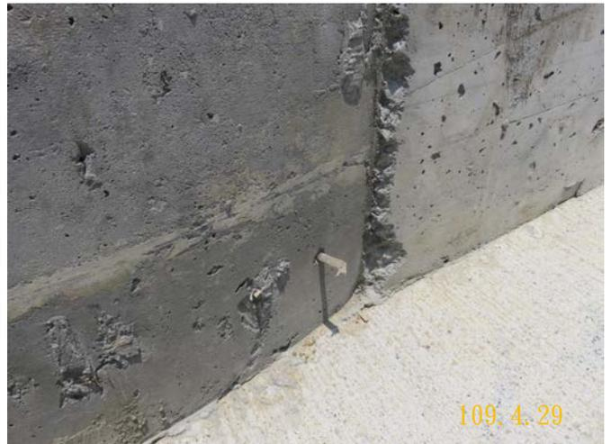
▶▶ 滯洪池周邊人行道緣石破損及部分鐵件未剪除
