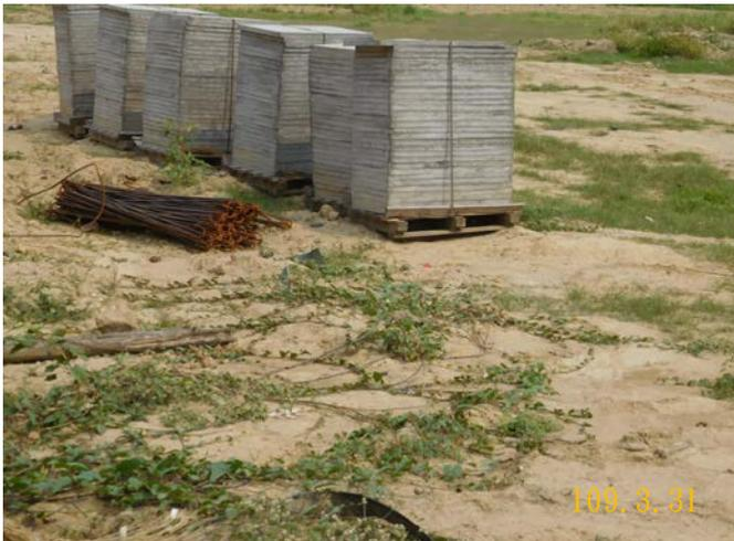
▶▶ 坵塊內已進場備用鋼筋直接放置於地面，未墊高隔離
