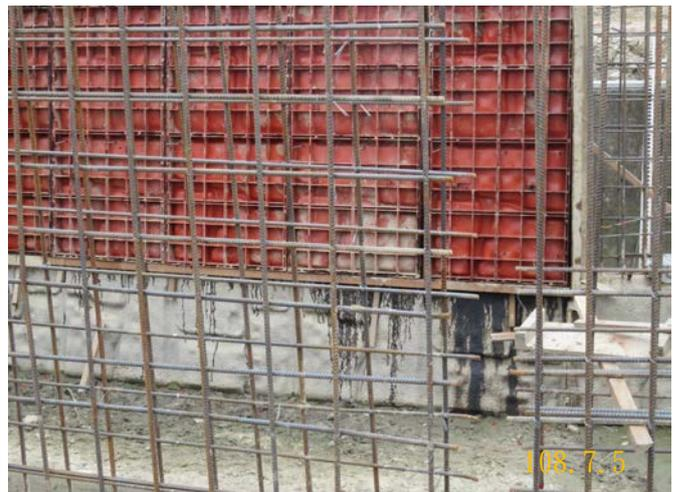
▶▶ 龍形溝明渠段鋼模塗黑色劣質油，污染牆面
