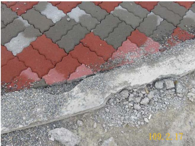
▶▶ 人行步道緣石混凝土完成面破損
