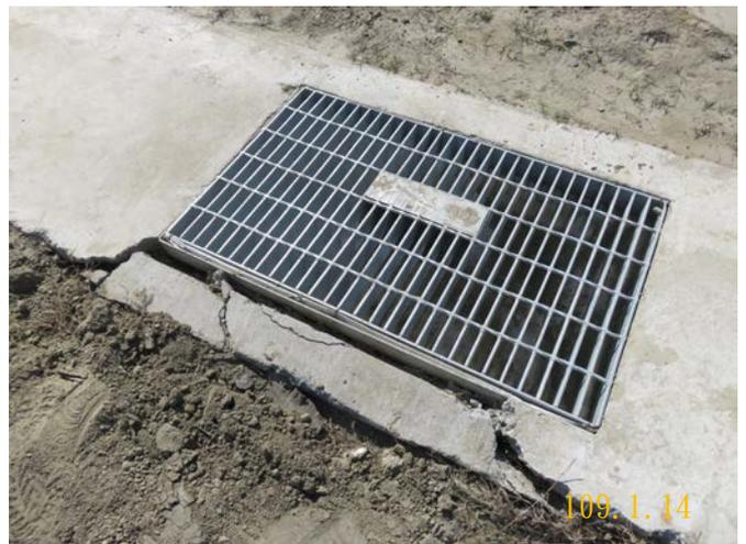
▶▶ 道路側溝蓋版及人孔之混凝土有多處遭碰撞破損情形
