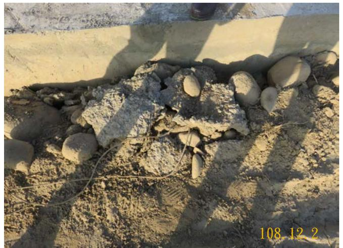
▶▶ 路基及坵塊部分回填材料不合規定，有混凝土殘料及粒徑過大卵石
