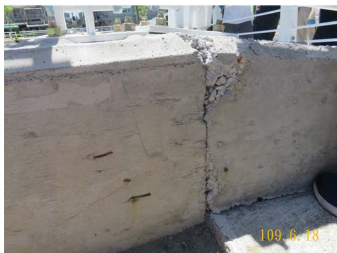
▶▶ 橋梁護欄基礎混凝土完成面，施工外觀平整度不佳
