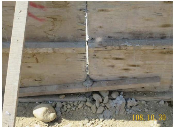
▶▶ 側溝模板破損嚴重及模板組立不緊密，有漏漿情形
