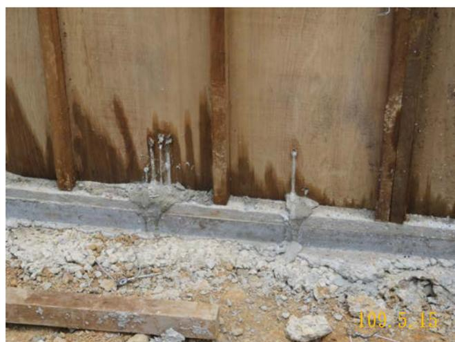
▶▶ 道路側溝側牆模板組合不緊密致混凝土漏漿情形
