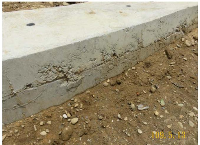
▶▶ 側溝外牆混凝土有蜂窩、孔洞未處理
