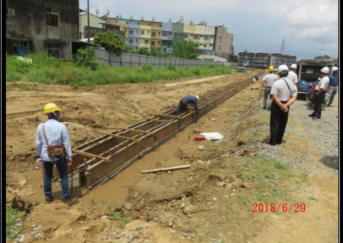
部分鋼筋直接放置於地面，而未墊高；建議施工廠商應落實自動檢查，並立即改善。
