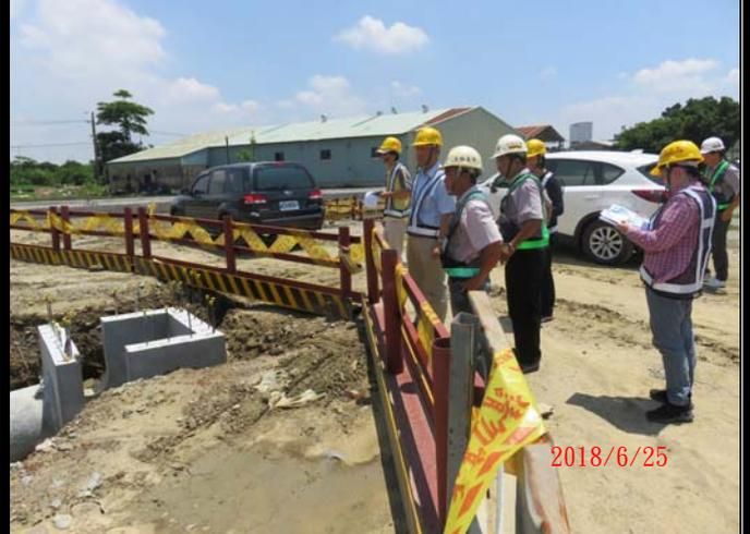
鋼筋材料未鋪蓋帆布；建議施工廠商應落實自動檢查，並立即改善。
