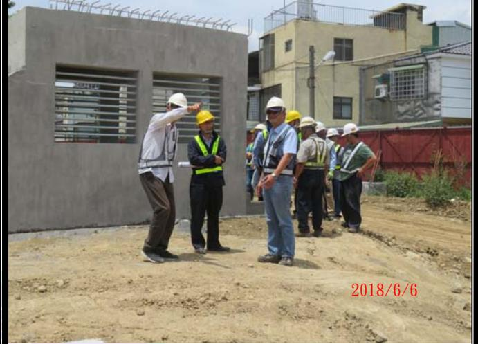
坵塊堆置剩餘土石方高度超過2公尺，未施設防塵網等保護設施；建議加強防塵網之覆蓋或灑水作業，避免揚塵。部分混凝土完成面有蜂窩情形；建議混凝土澆置時應澈底搗實，以降低表面產生蜂窩。
