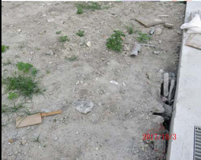
部分側溝蓋版有破損情形；建議施工廠商應落實自動檢查，並立即改善。
