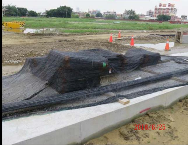
部分混凝土面有氣泡；建議混凝土澆置時應澈底搗實，以降低表面產生氣泡。
