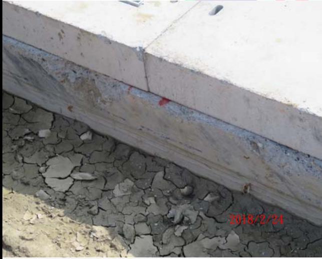
側溝溝蓋頂混凝土產生塑性裂縫；建議混凝土澆置完成後，應確實執行養護作業。
