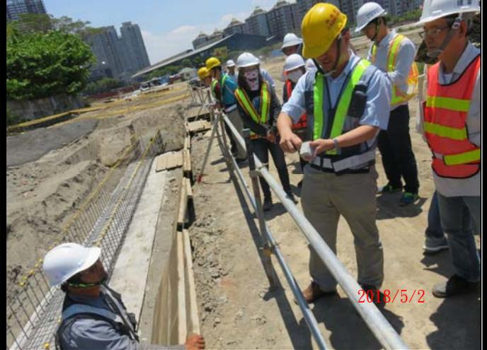
部分鋼筋未設置保護套等安全設施；建議施工廠商應落實自動檢查，並立即改善。
