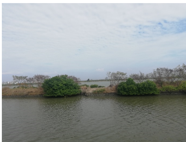
圖 2-2.10 B23 區閘門土堤修復完成圖
