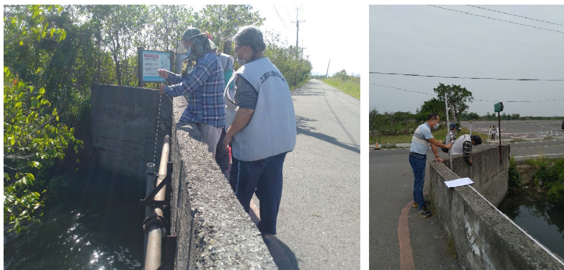
圖 2-3.3 W1 測站高程施測圖
