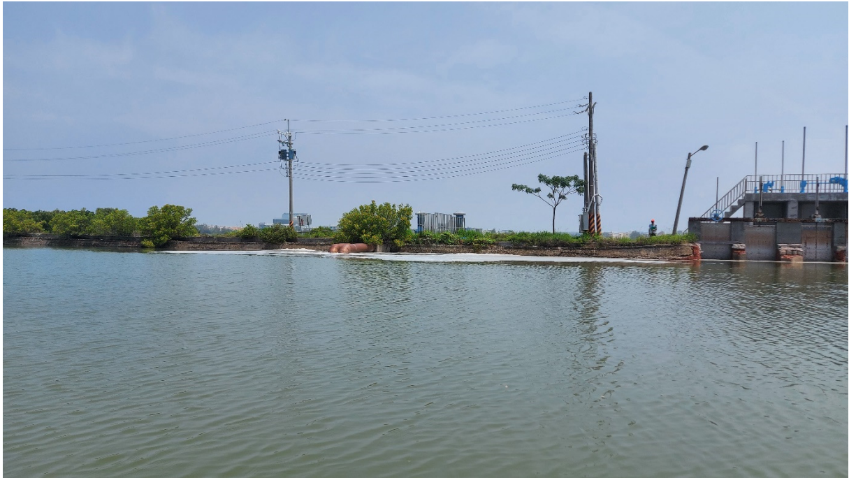
附圖 4-2.9 運鹽碼頭 MP2 抽水站(運鹽碼頭側)
