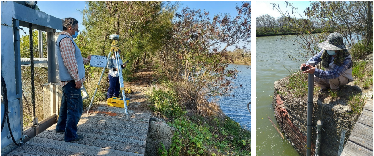
圖 2-3.7 M2 測站高程施測圖
