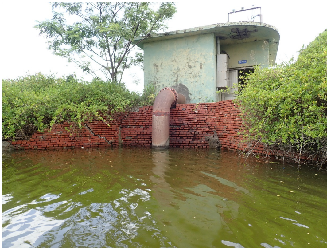
附圖 4-2.3 MP1 抽水站(運鹽古運河側)
