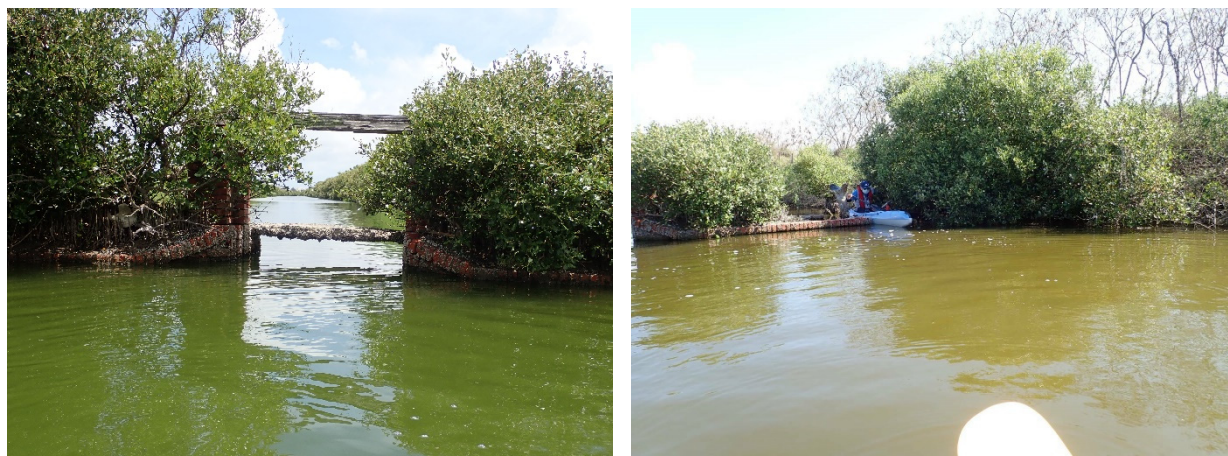
圖 2-2.12 東緣圳路河段 2 之跨圳路構造物圖
