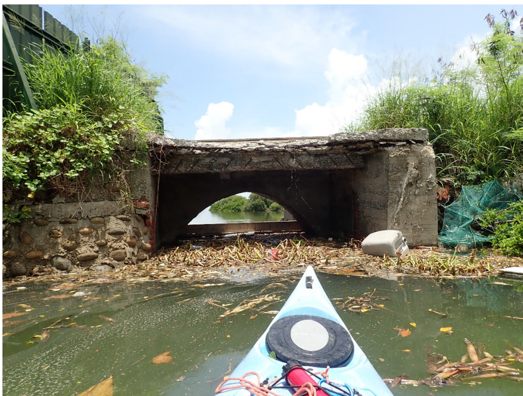
附圖 4-3.2 EG2 閘門(下游側)
