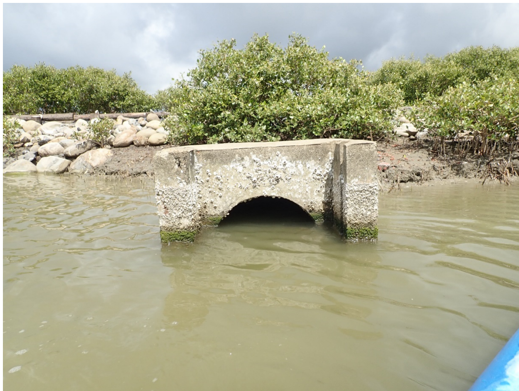
附圖 4-1.9 WC4 涵管(B10 區端)
