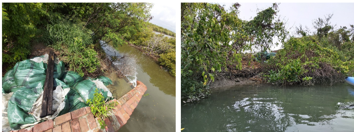
圖 2-2.7 B7 區閘門北側堤岸崩壞擊破口狀況圖
