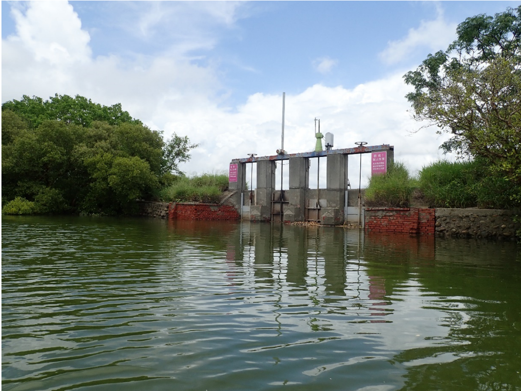
附圖 4-2.1 MG1 閘門(運鹽古運河側)
