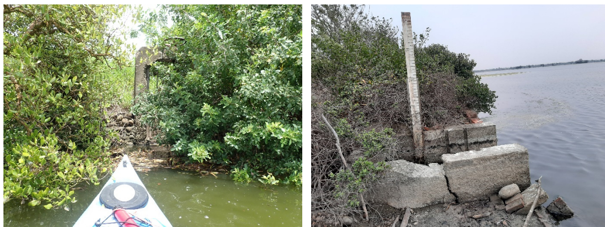
圖 2-2.15 鹽水溪排水 SG1 閘門概況圖
