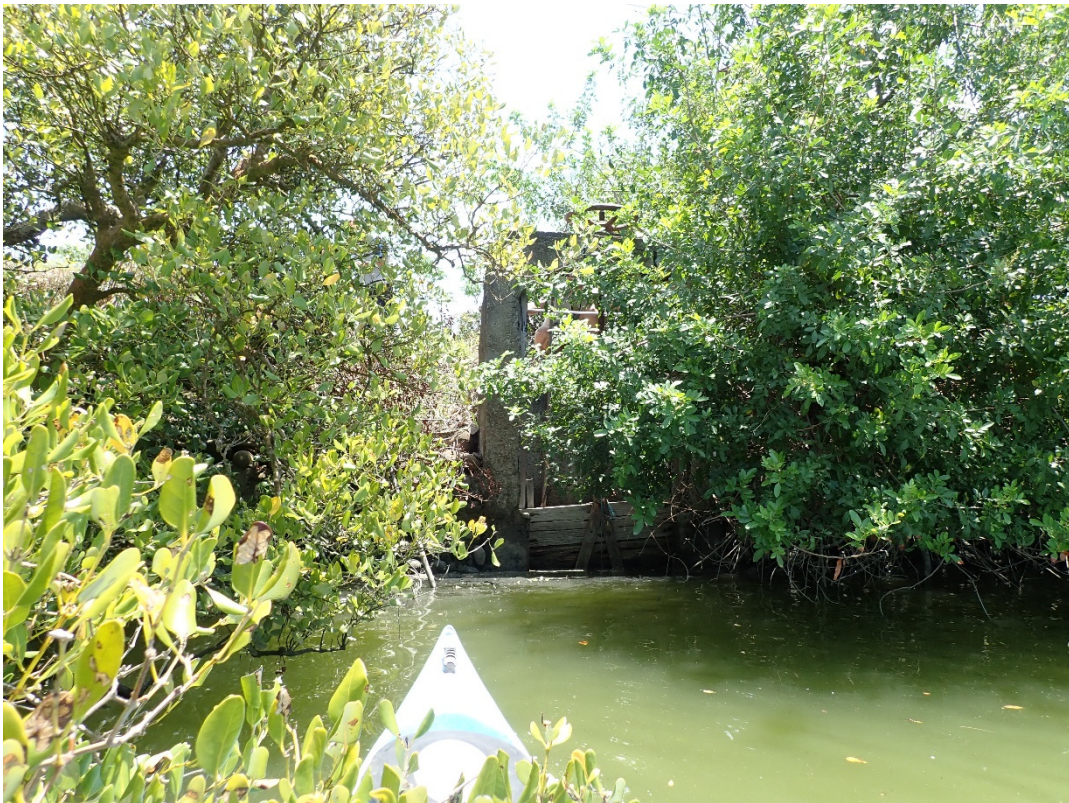
附圖 4-2.2 MG2 閘門(運鹽古運河側)
