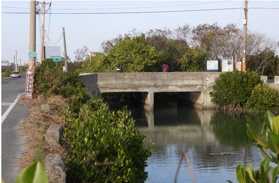
附圖 4-1.1 WC1 道路箱涵(下游側)
