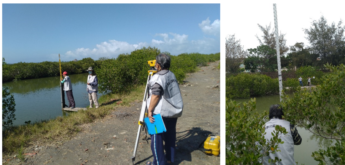
圖 2-3.5 W3 測站高程施測圖
