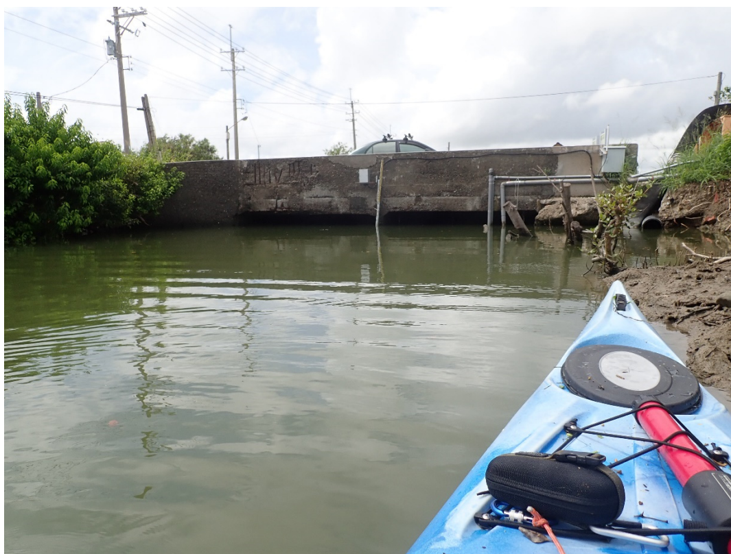
附圖 4-1.6 WC2 道路箱涵(下游側)
