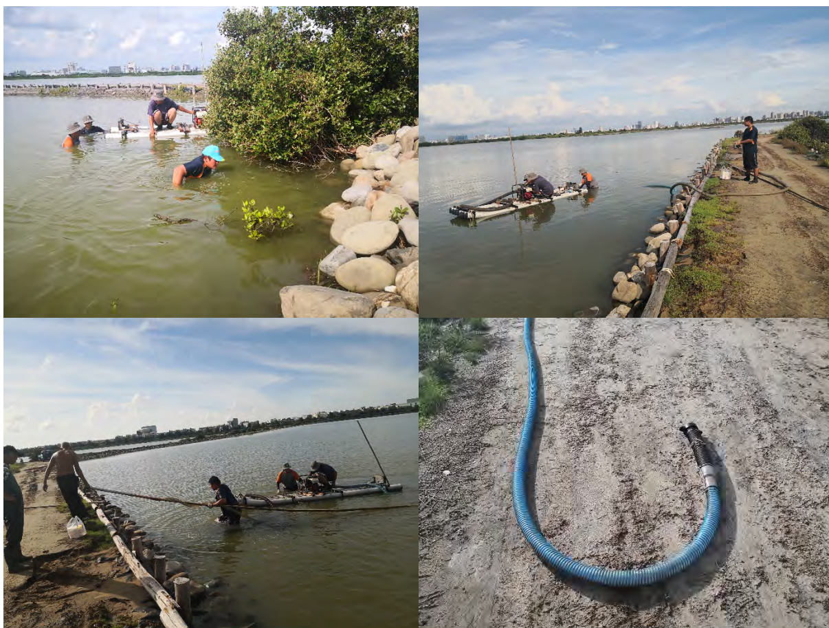
圖 3-2.2 109 年 B4 及 B16 樣區涵管清通作業圖
