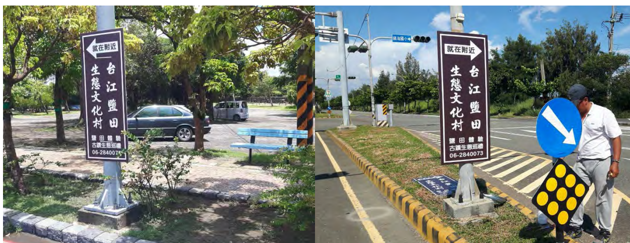
圖 6.1-3 路標指引看板現場安裝情形
