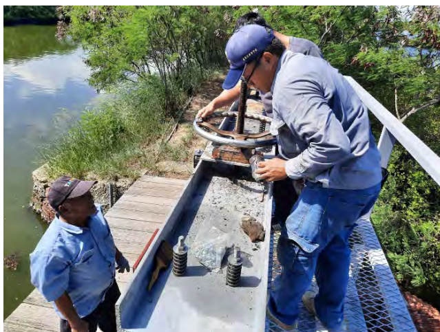
圖 2-3.2 B8 樣區東側防潮閘機件整修作業
