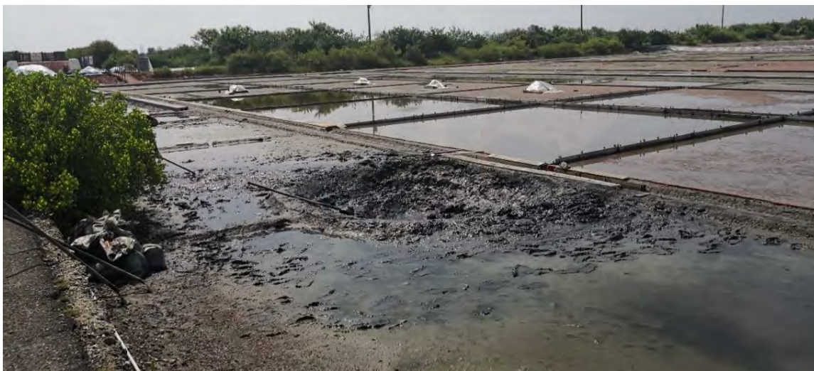
圖 5-2.1 原有鹽鹵池淤泥挖除浚深作業
