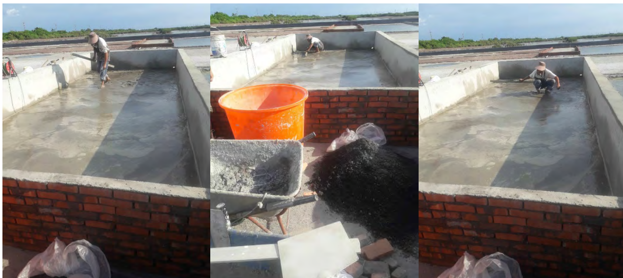
圖 5-2.4 修建鹽滷池水泥沙漿粉刷作業圖
