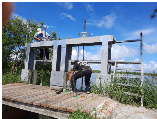
圖 2-3.2 B8 樣區東側防潮閘機件整修作業
