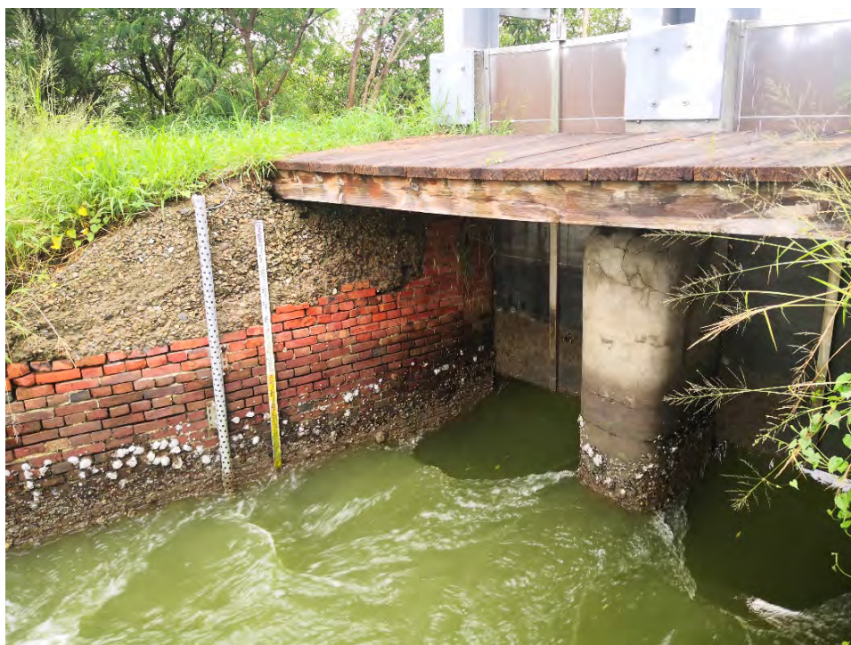
圖 2-3.4 109 年 8 月 31 日東側防潮閘兩座水門退潮期間試排水操作圖
