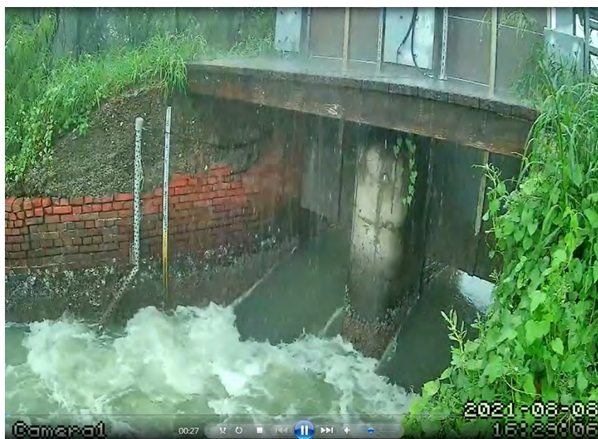
圖 4-6.2 110 年 8 月豪大雨期間 B8 樣區東側防潮閘雲端開啟排洪圖
