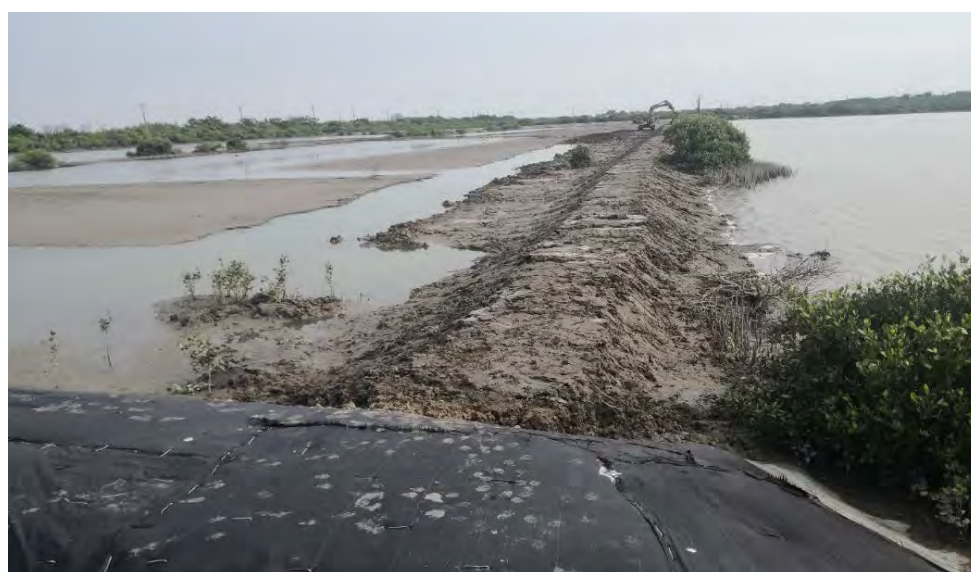
圖 2-2.4 示範試驗區淺灘區與深水區間土堤修復作業圖
