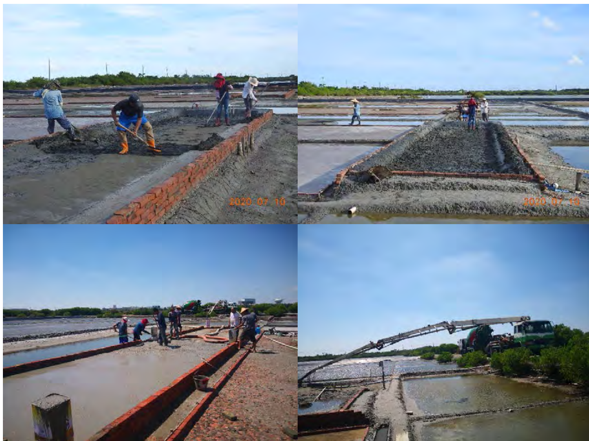
圖 5-2.3 修建鹽滷池整地、底部基礎及柱體灌漿作業圖
