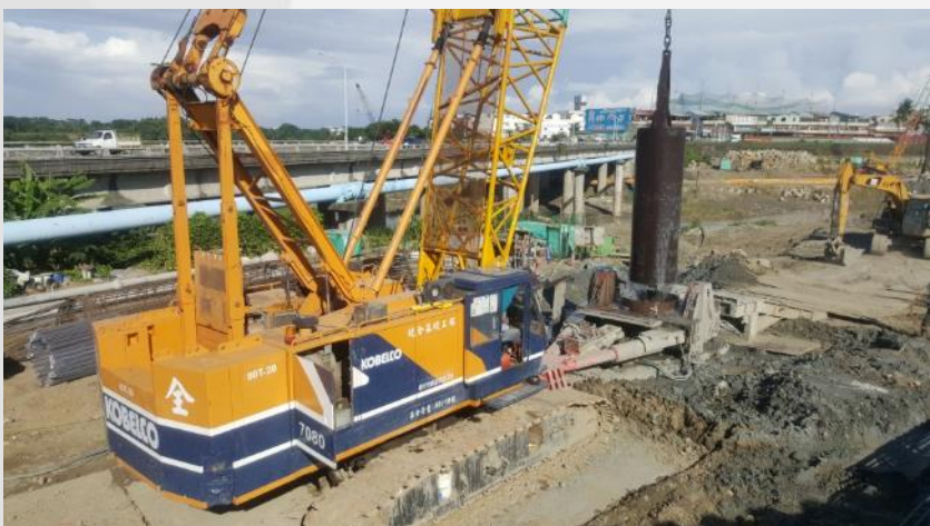
P1-全套管基樁鑽掘
