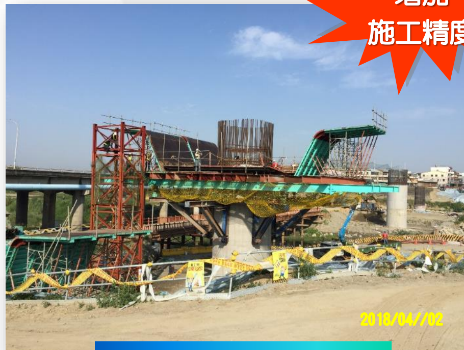
翼板底模吊裝鎖固
