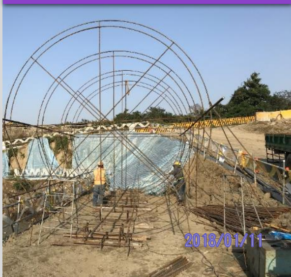
墩柱鋼筋樣架地面組立
