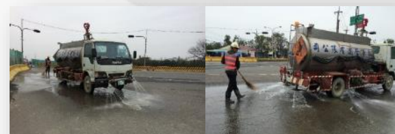
灑水車汲取使用洗掃工區
