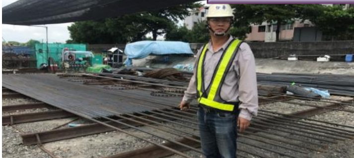
全套管基樁鋼筋籠施工督察
