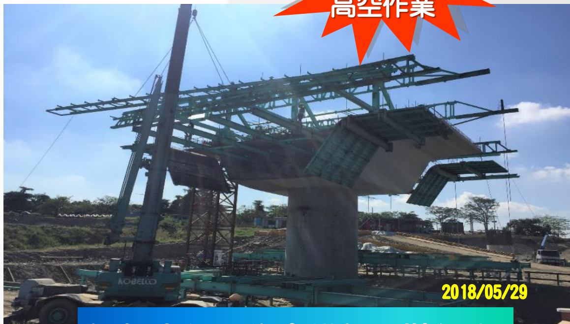
欄杆先行工作車模板吊裝組立
