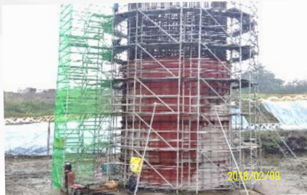
橋墩柱使用鋼模模板
