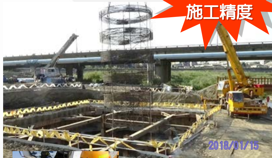
墩柱鋼筋樣架吊放
