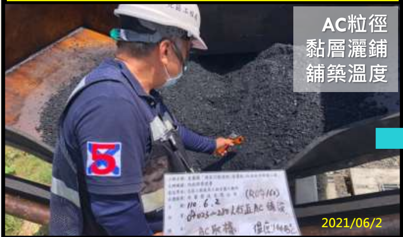
人行道密級配材料檢驗(鋪裝機)
