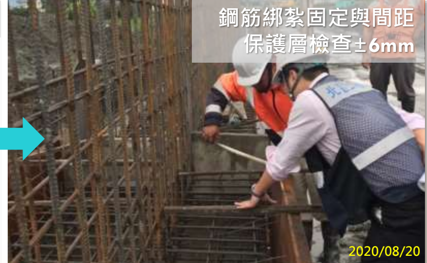
鋼筋綁紮檢查
