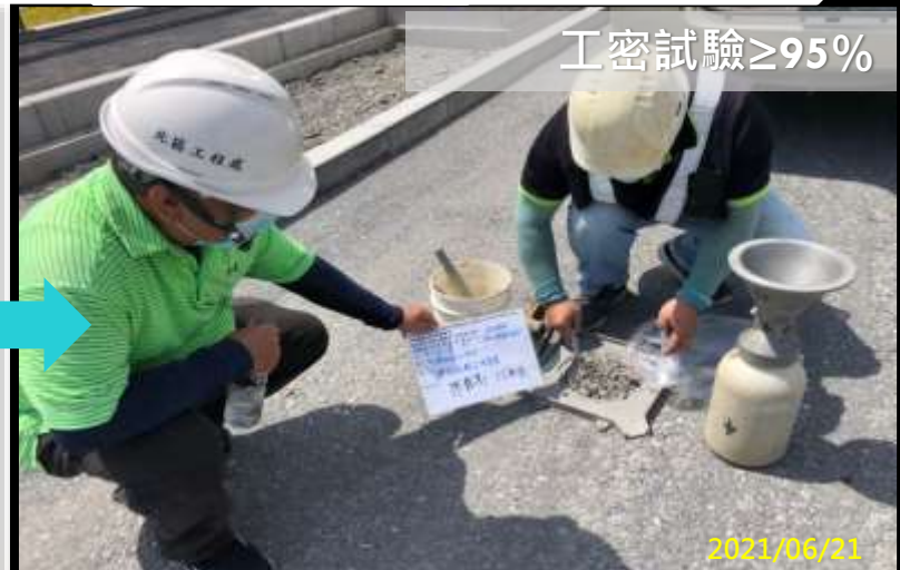
碎石級配工地密度試驗
