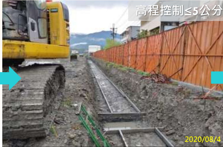
開挖與PC打底高程控制
