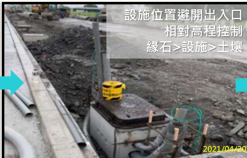
進水井與管線手孔埋設
