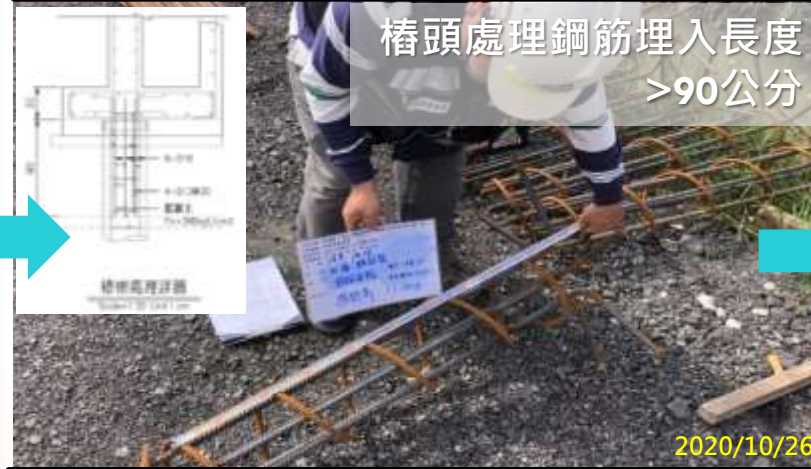
PC樁樁頭處理
