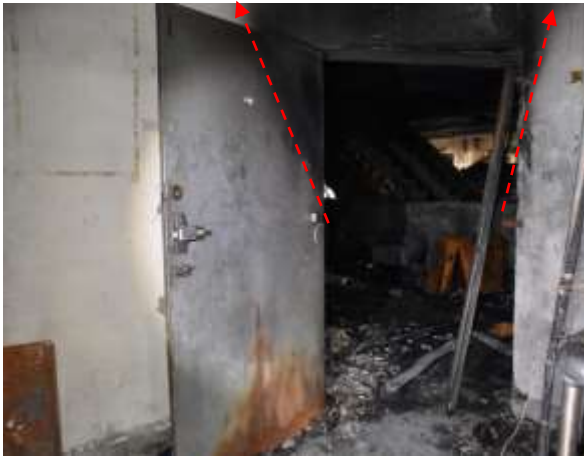
照片 13 (左) 3 樓 B 梯防火門呈開啟狀態，外觀有 V 型煙燻痕跡。
