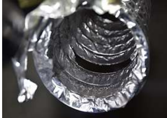
照片（右）浴室天花板上方排風管內側附著有碳粒子，管路有局部破損情形。
