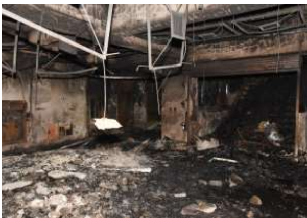
照片 11 (左) 3 樓空間受燒損情形嚴重，手扶梯開口通往 4 樓之鐵捲門未關閉。
