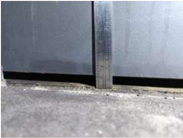
照片（左）房間門北段外側與地板約有 1.1 公分縫隙。
