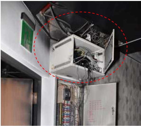
照片 31、32 9樓B梯管道間之配線填塞情形。
