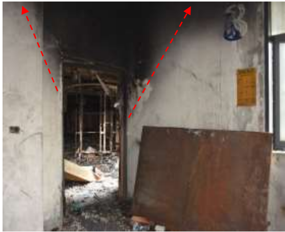
照片 13 (左) 3 樓 B 梯防火門呈開啟狀態，外觀有 V 型煙燻痕跡。
