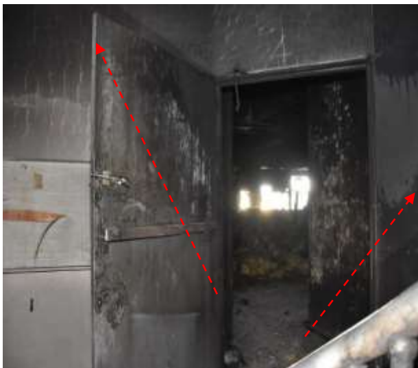
照片 17 (左) 4 樓 B 梯防火門呈開啟狀態，門口呈 V 型煙燻痕跡。
