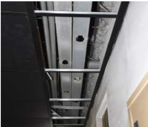
照片（左）浴室排風管連接至塑膠管，開口貫穿至走道天花板上方。
