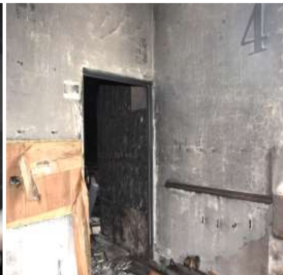
照片 17 (左) 4 樓 B 梯防火門呈開啟狀態，門口呈 V 型煙燻痕跡。
