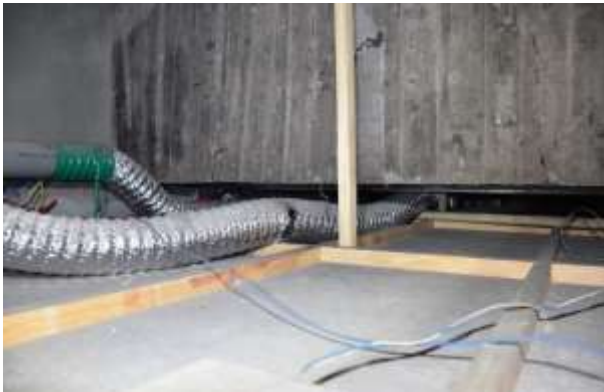
照片（左）天花板上方東北側配置情形，有浴室排風管連接至塑膠管，其中一條排風管貫穿牆面至北側房間，天花板上層有碳粒子殘留。
