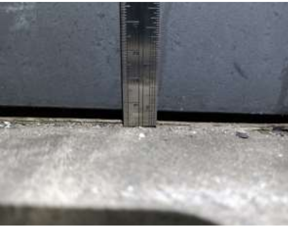
照片（左）房間門南段外側與地板約有 0.7 公分縫隙。
