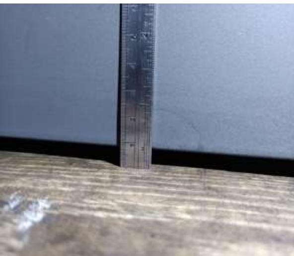
照片（左）房間門北段內側與地板約有 1 公分縫隙。
