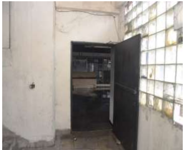
照片 9 (左) 2 樓 B 梯防火門未關閉，外觀呈北低南高煙燻痕跡。
