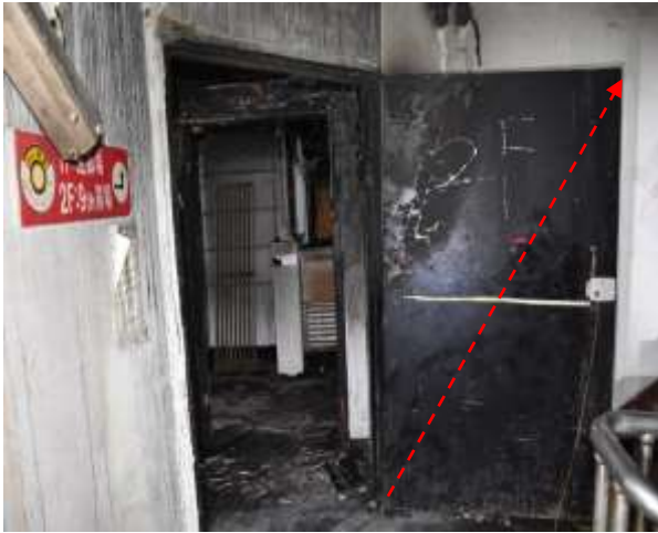
照片 9 (左) 2 樓 B 梯防火門未關閉，外觀呈北低南高煙燻痕跡。
