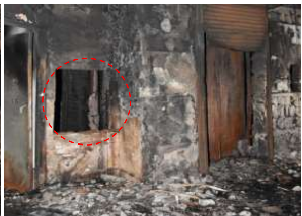
照片 11 (左) 3 樓空間受燒損情形嚴重，手扶梯開口通往 4 樓之鐵捲門未關閉。
