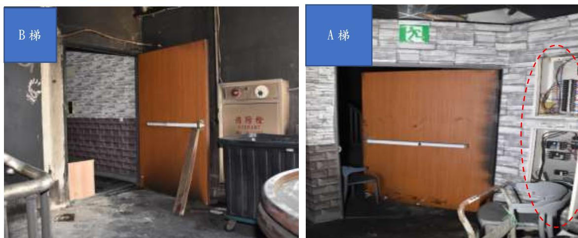
照片 22 6 樓 A、B 梯防火門受些微煙燻，B 梯旁管道間密閉。
