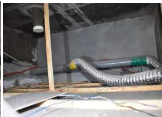
照片（左）天花板上方東北側配置情形，有浴室排風管連接至塑膠管，其中一條排風管貫穿牆面至北側房間，天花板上層有碳粒子殘留。
