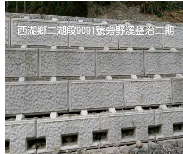
生態預鑄槽護岸
