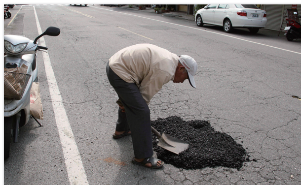
謝里長於颱風過後親自修補道路坑洞
