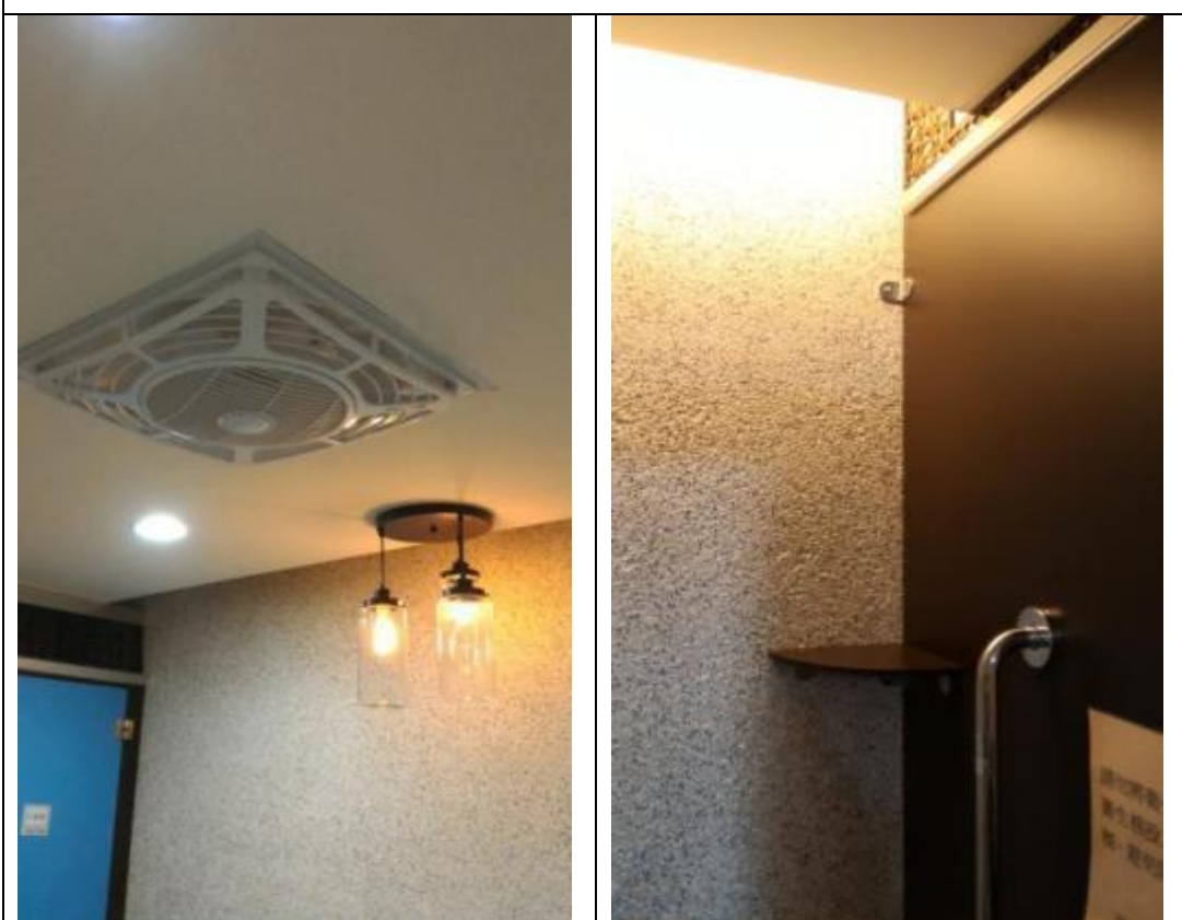
圖 13-5 廁所內採機械換氣，減少廁所臭味。(來源：內政部建築研究所，104)
