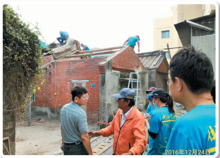
陳里長請衡山基金會協助低收入戶里民修繕屋頂
