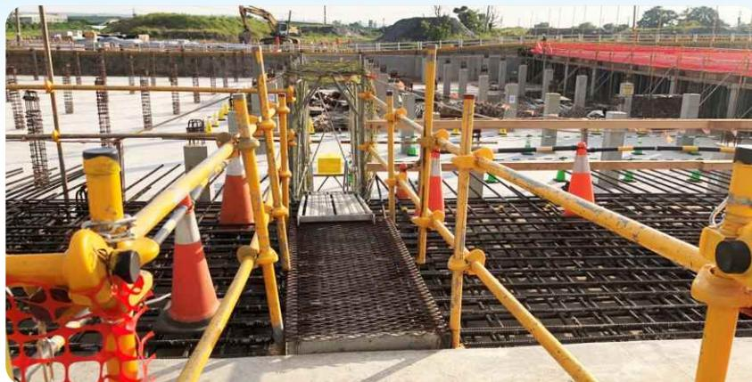
▲ 圖 4-9 臺中市烏日竹地區區段徵收工程第三標 - 滯洪池施工作業場所上下設備
