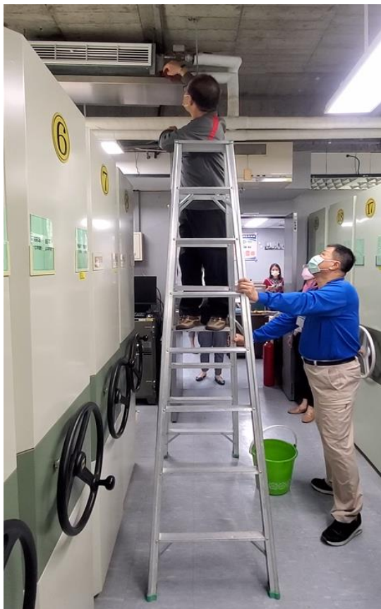
實地演練 6—環境控制組成員以抹布於冷氣集水盤吸水，初步控制滴水情形。
