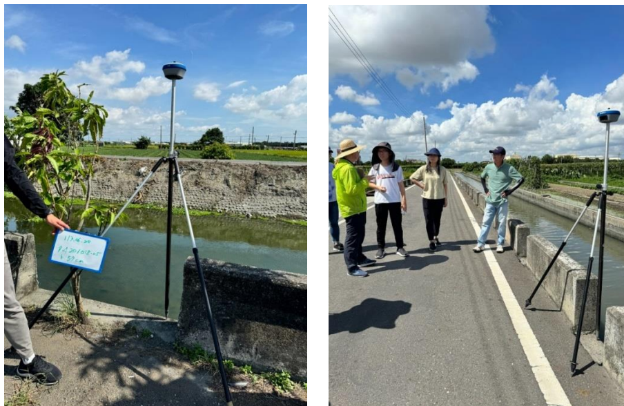
圖 4.2-11 溢堤線驗收作業照片
