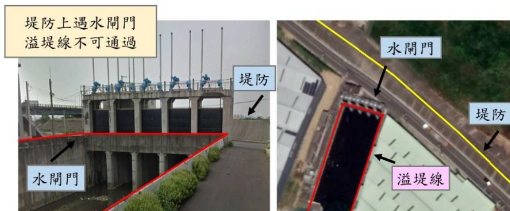
圖 3.3-11 溢堤線遇堤防之水閘門時測繪原則
