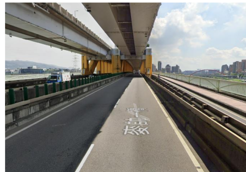
圖 2-32 自行車道與機車專用道切分原則例外情況(麥帥一橋機車專用道)
