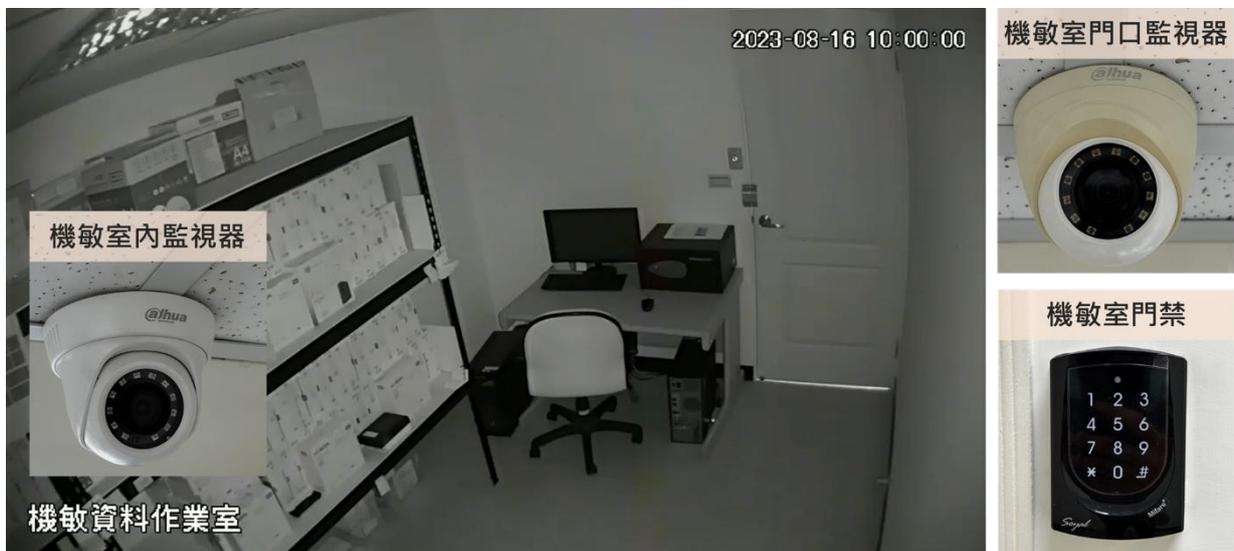
圖 1-2、機敏資料作業室門禁管制和監視器設備
